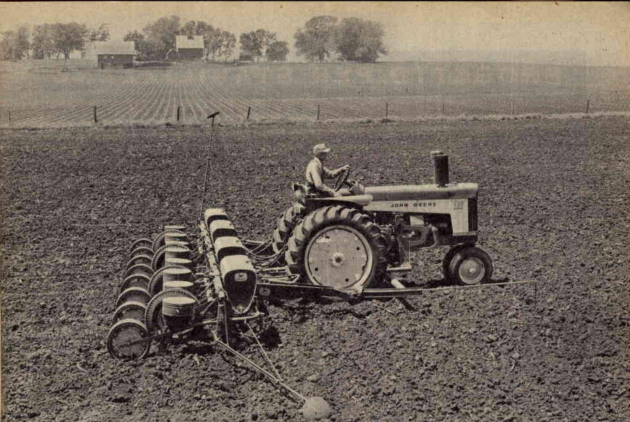
Sopra: Il nuovo 'piantatore' permette la semina di 8 solchi alla volta, con trattore per aratura di 5 solchi. Sotto: Il più grande aratro mai prodotto, per 8 solchi profondi 40 cm., viene sollevato facilmente dal nuovo trattore da 10 tonnellate '8010'. Il complesso degli aratri pesa 2.500 kg. Finora il più grande aratro era a 4 file. Questo modello con la rimanente attrezzatura del peso di 3½ tonn. è stato realizzato per essere usato con il trattore '8010'.
